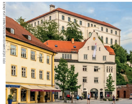
Das generalsanierte Gebäude auf dem Domberg präsentiert sich äußerlich wie innerlich in neuem Gewand.
